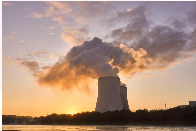
내륙 발전소가 폐열을 내보내는 대형 냉각탑. 강물의 열 오염을 예방하지만 수증기가 주변 지역 햇빛을 가리는 폐단이 있음.
